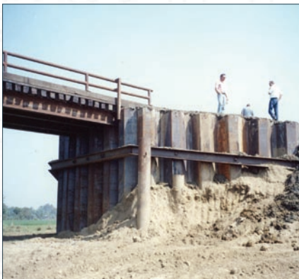
Элементы конструкций, предохраняющие дороги от оползней
