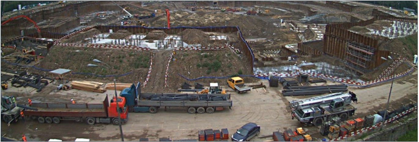
Строительство спортивных сооружений
