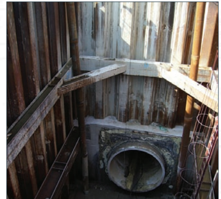
Котлованы для построения канализационных коллекторов при новой очистке сточных вод
