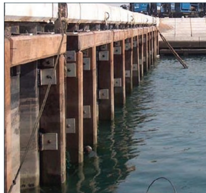
Укрепление набережных, причалов, берегов рек и водоемов
