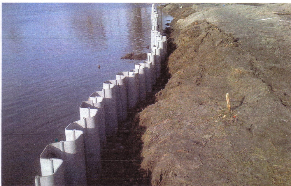
Рисунок 1 - Вариант устройства шпунтовой стенки при укреплении береговой зоны
